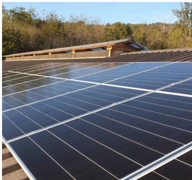
Foto 1. Impianto fotovoltaico terminato
