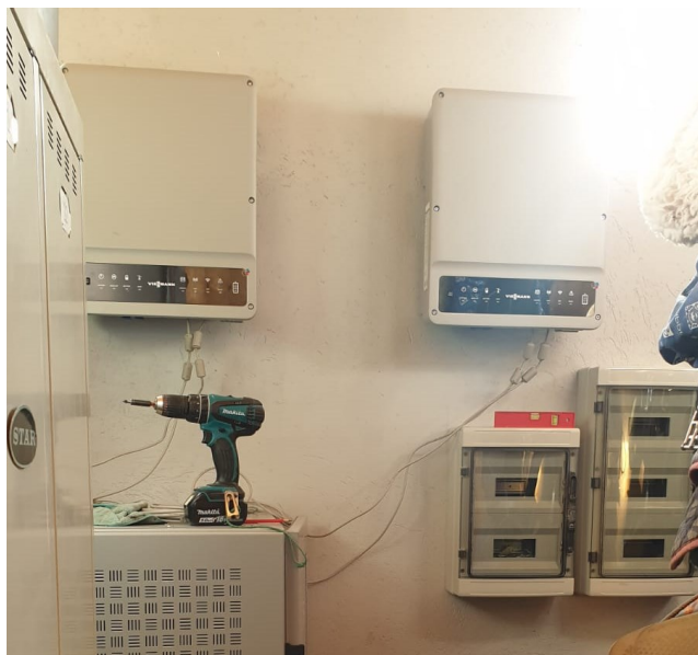
Foto 2. Inverter VIESSMANN e quadri elettrici
