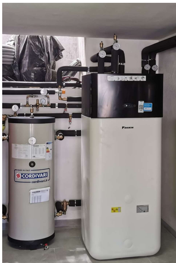
Foto 1 Macchina interna pompa di calore elettrica EPRA18
