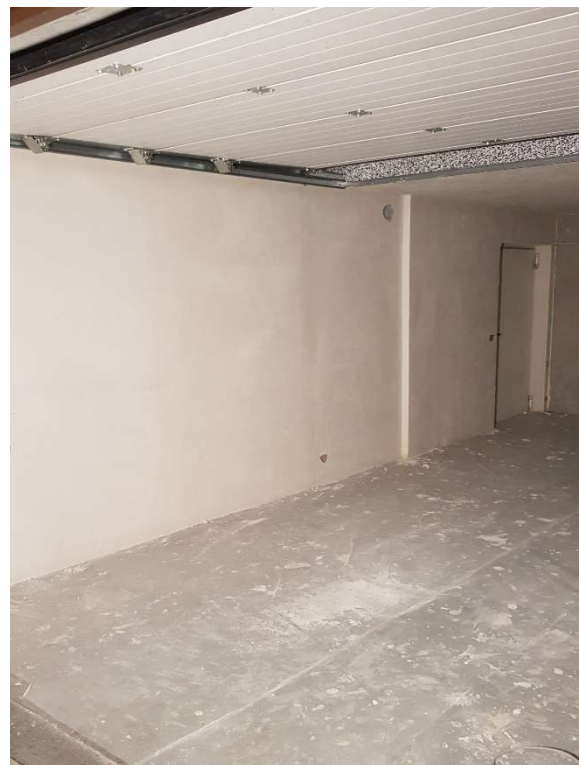
Foto 6-7 Posa di isolante e finitura parete verso locale non riscaldato
