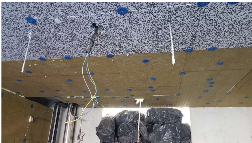
Foto 8 Posa di isolante solaio verso locale non riscaldato
