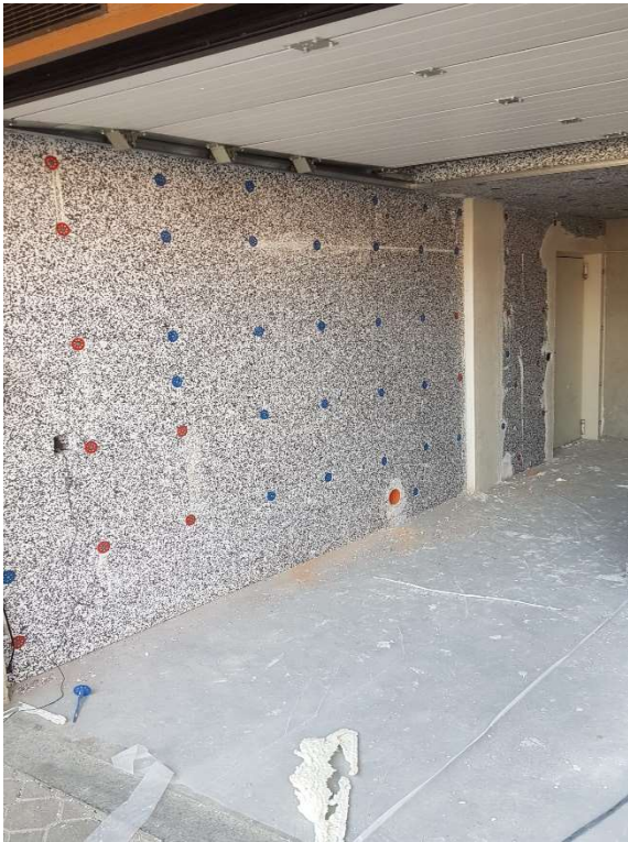
Foto 6-7 Posa di isolante e finitura parete verso locale non riscaldato
